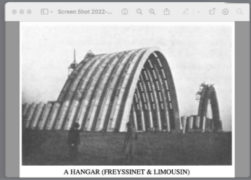
A HANGAR (FREYSSINET & LIMOUSIN)
